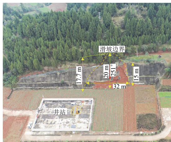
图 2 四川省遂宁市安居区某油气井站边坡研究现场
