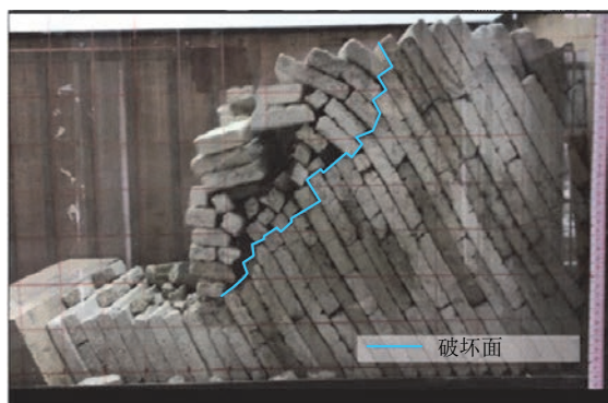
(b) 边坡倾倒破坏阶段
