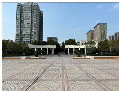
图5 二厂露天广场现状
