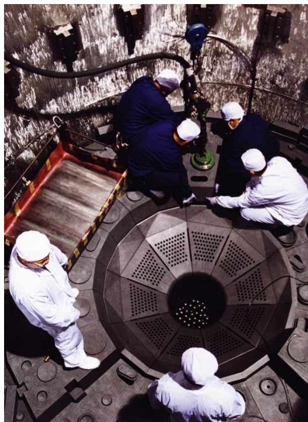
图5 10 MW高温气冷实验堆石墨堆内构件安装 [1]219 （1999年11月，王呈选摄）
